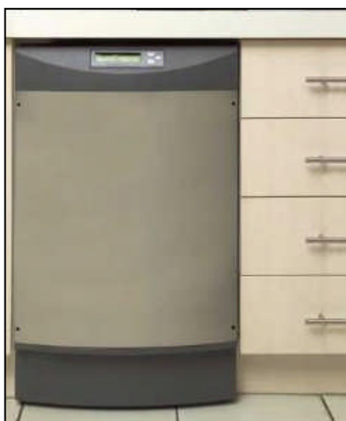
Gas betriebene KWK von WhisperGen als Untertisch-Standgerät mit Wobbelscheiben- Stirlingmotor
